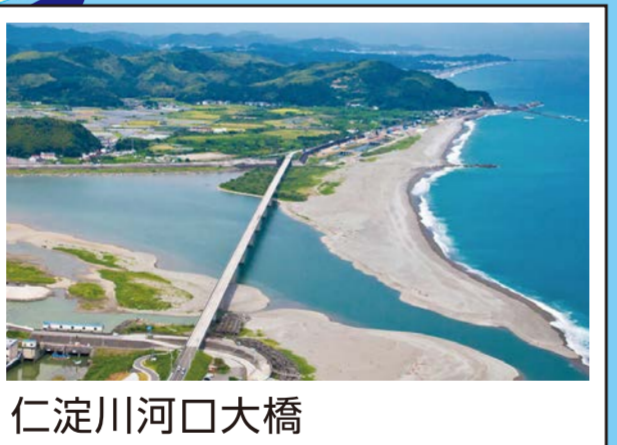
仁淀川河口大橋
